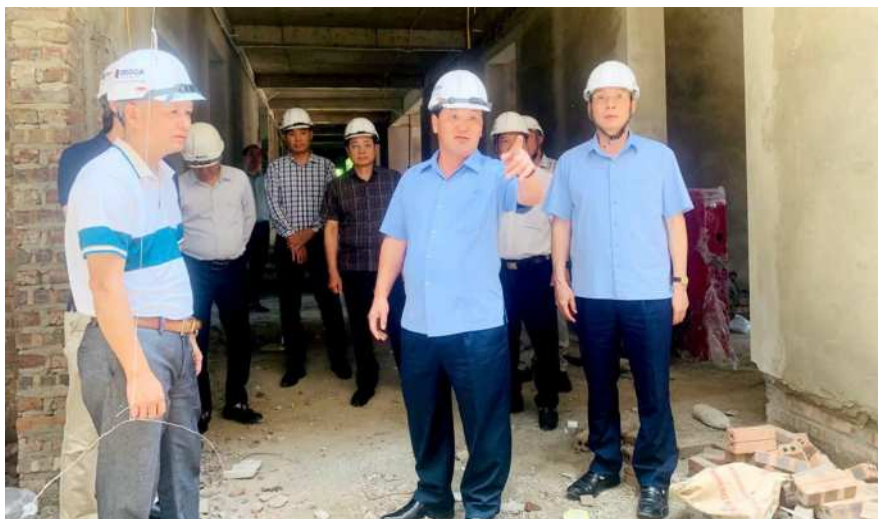
Bí thư Tỉnh ủy Hầu A Lềnh kiểm tra tiến độ xây dựng Khoa Khám, chữa bệnh Bệnh viện Đa khoa huyện Quán Bạ
