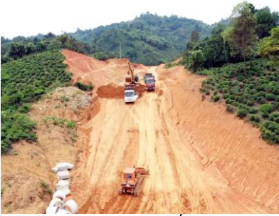
Thi công xây dựng tuyến đường cao tốc Hà Giang - Tuyên Quang
